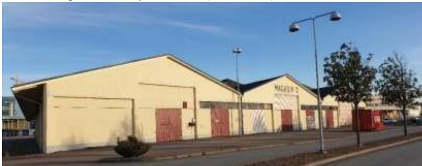
Foto 3 - Magasin D, sett från väster. (Norconsult)
