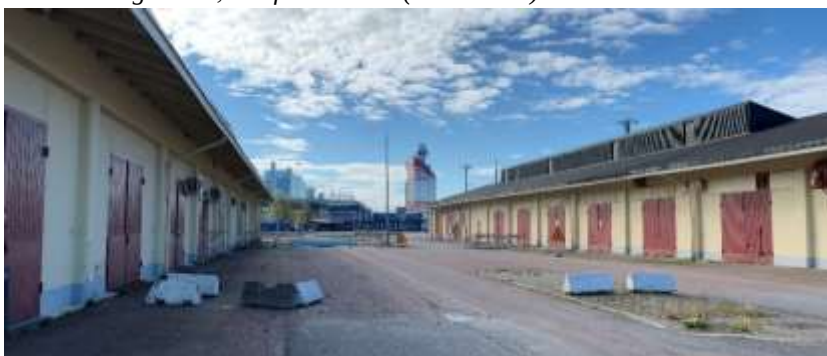
Foto 4 - Lastgatan mellan Magasin E och Magasin D, sedd från väster. (Norconsult)
